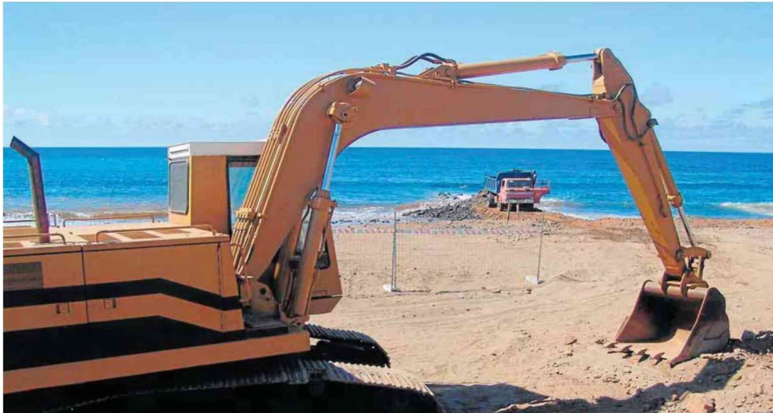
Obras de construcción del actual desagüe de la playa de Bocabarranco, en la costa de Gáldar, ejecutadas en 2004, hace ya más de 20 años. c7
