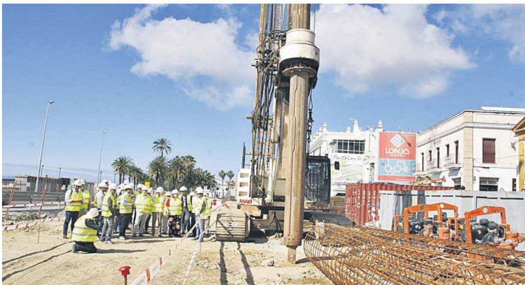
Una visita a las obras del aparcamiento de Pozos Dulces en 2018, siendo alcalde el socialista David de la Encina.
